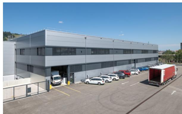
15 mètres de haut. Les locaux techniques sont finis avec un béton taloché qui assure une surface lisse, durable et facile à nettoyer. Une résine époxy couvre l'entier de la surface de production. Une paroi intérieure coupe-feu a été construite en panneaux sandwich de laine minérale. Un système de rétention d'eau de pluie a été installé sur la toiture et dans un bassin d'infiltration, sans aucune liaison au réseau communal. Seules les eaux usées ont été raccordées.
