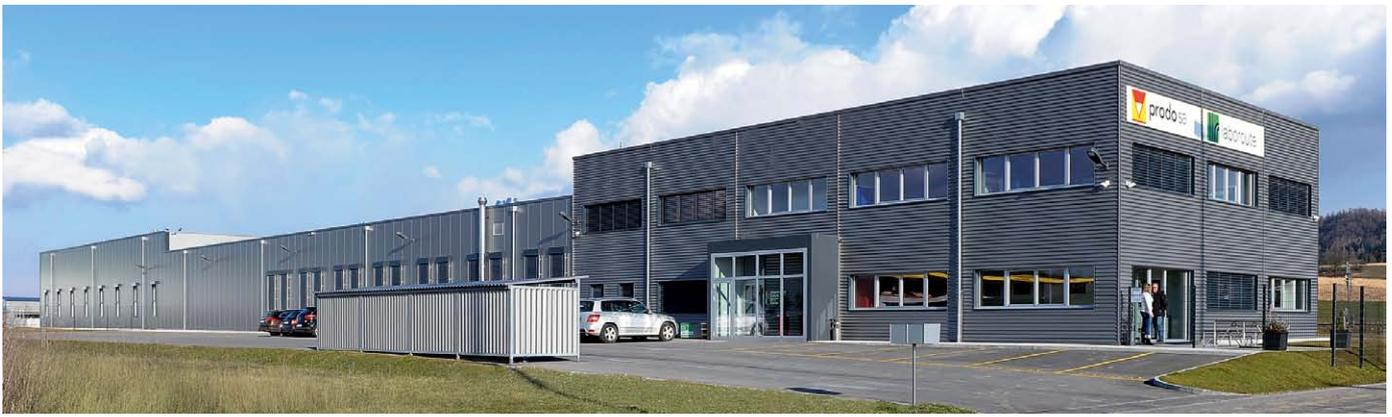
La partie administrative est dotée d'une paroi ventilée qui apporte un plus grand confort thermique et phonique aux usagers. Le reste des façades de la halle, consacrée aux laboratoires et au stockage, a été réalisé en panneaux sandwich. Autre particularité, l'ensemble du concept d'éclairage du bâtiment fait appel aux LED afin d'économiser de l'énergie et favoriser le développement durable.
